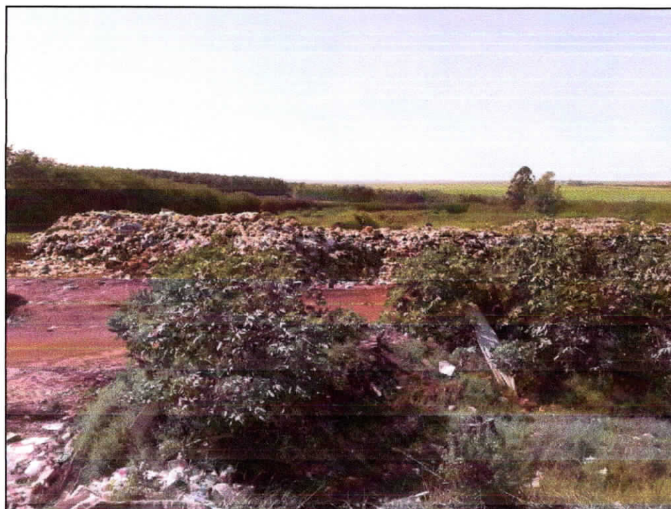
Figura 06 – Vista parcial do aterro controlado– Junho/2014 Fonte: Prefeitura Municipal de Paranacity
